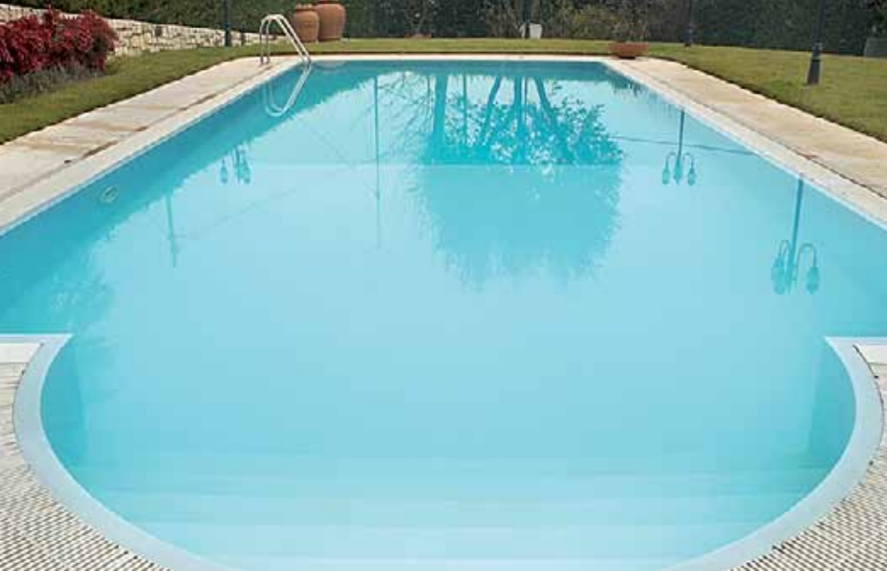
INSTALLATIONS POUR PISCINES
