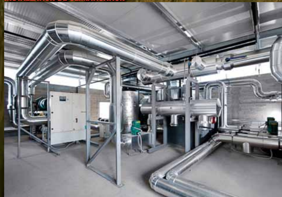
INSTALLATION DE CLIMATISATION
